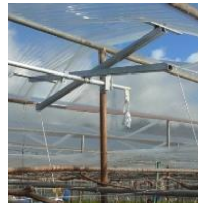
ぶどうハウスの自動換気装置
